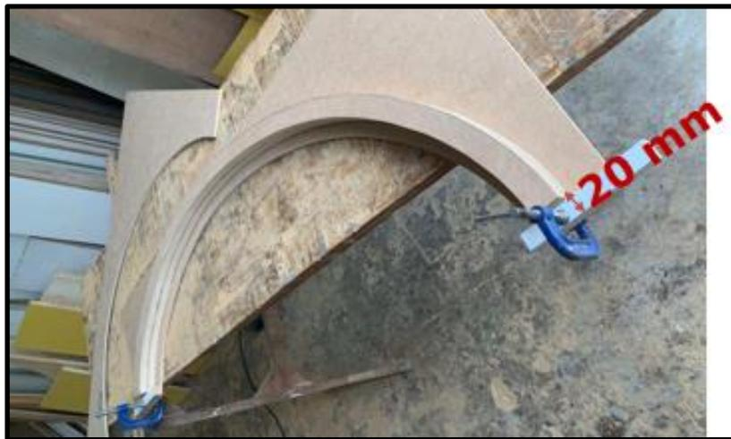
**Figura 28** - Fixação do preenchimento curvo na face lateral do MDF de 6 mm.
