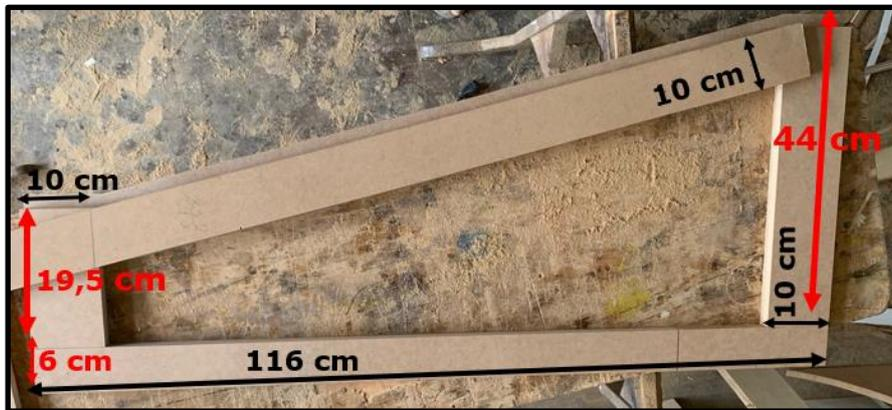
**Figura 32-** Preparação para a montagem da peça de preenchimento da rampa reta.
